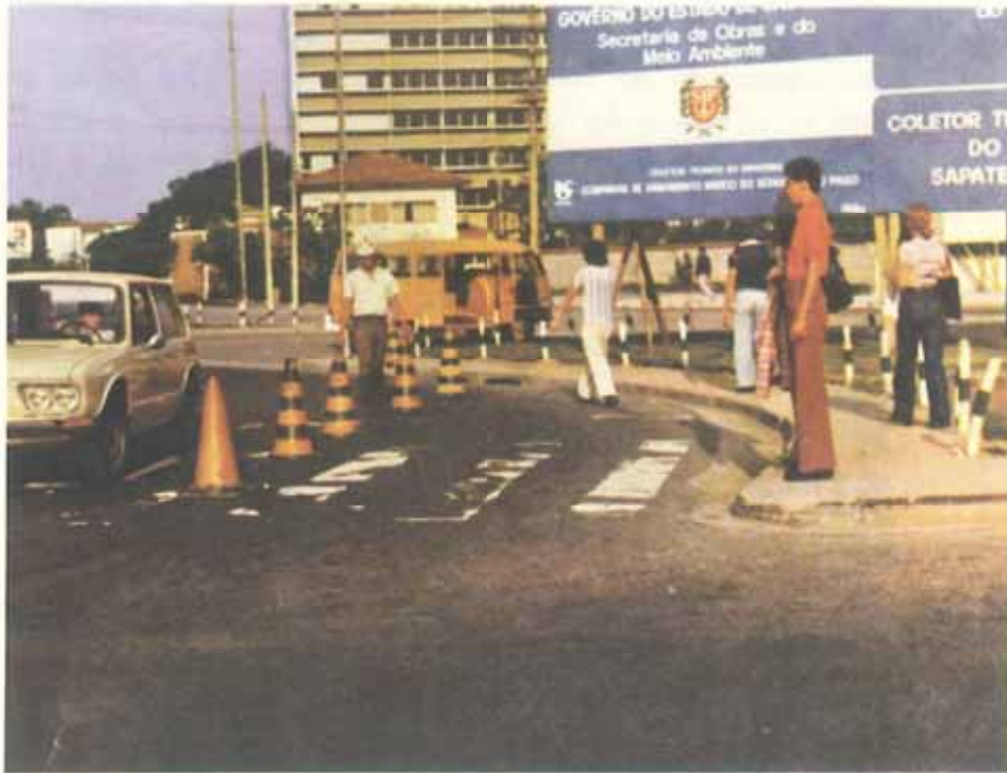
FIG. 7 — IMPLANTAÇÃO DE DESVIOS E CANALIZAÇÕES TEMPORÁRIAS.
